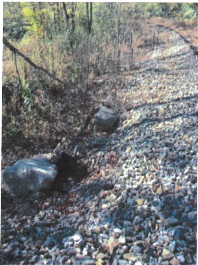
Stone Culvert milepost CAJ 0.5
