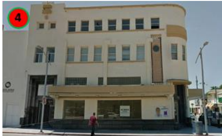
Antiguo Edificio de Correos
