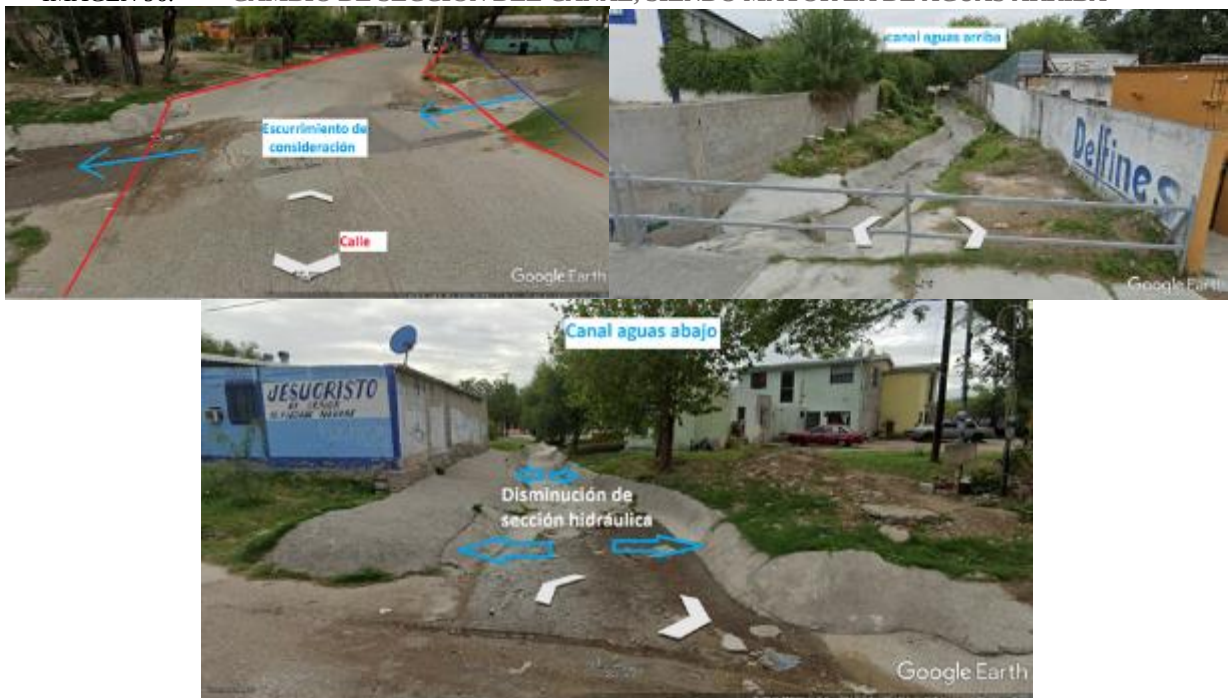
IMAGEN 96. CAMBIO DE SECCIÓN DEL CANAL, SIENDO MAYOR LA DE AGUAS ARRIBA
