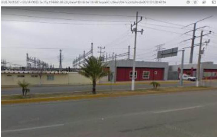
IMAGEN 66. SUBESTACIÓN ELÉCTRICA PIEDRAS NEGRAS
