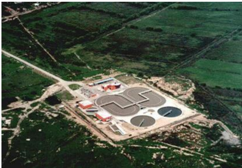
IMAGEN 65. IMAGEN DE PLANTA DE TRATAMIENTO DE AGUAS SERVIDAS
